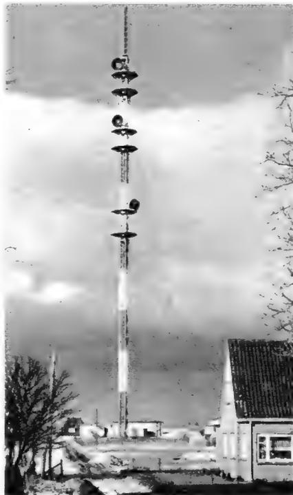
Bild 10. Abgespannter Mast mit Betriebs- und Maschinengebäude bei einer Richtfunkstelle mit Fernsehsender, Parabol- und Muschelantennen und Fernseh-Sendeantenne (Foto: OPD Kiel)
